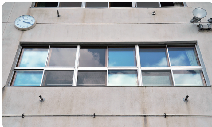
初夏の教室では、意図的に内窓を引き開けて外窓だけにする。すべて閉めると外気を遮断され、この時期は室内が寒く感じるという。土地柄に合わせて使い方が工夫されている
