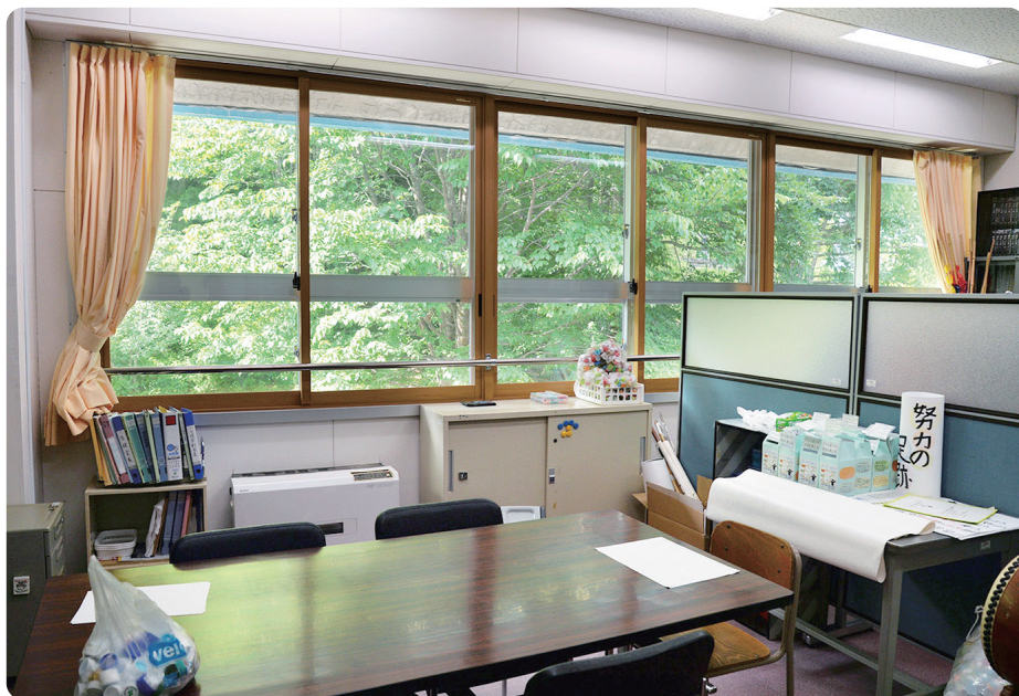
北向き窓のある生徒会室にも内窓を設置。子どもたちが自ら学校運営を考えるスペースでの環境教育にもひと役買っているかも
