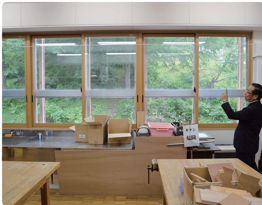
1階の技術室には高さ1.7mの窓が連なる。北を向く窓のすぐ近くまで裏山が迫り、冬場は冷気をまともに受ける厳しい環境だった
