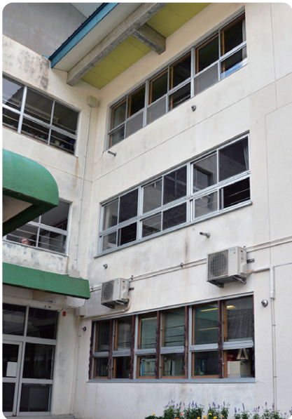
昇降口脇の3箇所が“おためし先”となった。1階職員室と3階教室は内窓設置、2階の教室はサッシも含め窓全体をエコガラスに交換
