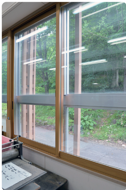
窓外に見えるのは雪囲い用の木枠。積雪は窓いっぱいの高さになることもある
