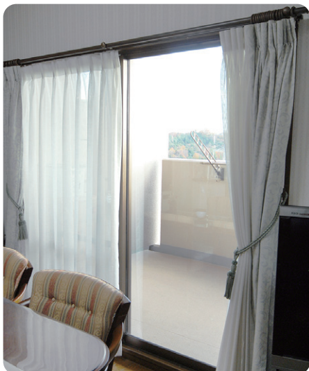
バルコニーへの出入り口となる掃き出し窓は、既存のサッシをそのまま生かしてガラスだけをエコガラスに入れ替えた
