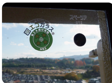
掃き出し窓に使われたのは、エコガラスの一種である真空ガラス。中間層を真空にし、薄手で高い断熱性能を備える。並んでいる黒い点は中間層内のスペーサー
