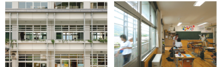
（使用したガラス） ● エコガラス（Low-Eガラス5ミリ+中空層6ミリ+フロートガラス5ミリ、Low-Eガラス3ミリ+中空層6ミリ+フロートガラス3ミリ）、ペアガラス（フロートガラス5ミリ+中空層6ミリ+フロートガラス5ミリ、フロートガラス3ミリ+中空層6ミリ+フロートガラス3ミリ）
